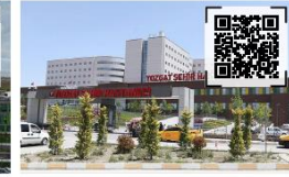
Yozgat Şehir Hastanesi
