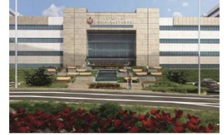
Kütahya Şehir Hastanesi
