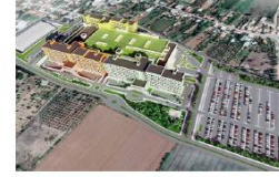
Aydın Şehir Hastanesi
